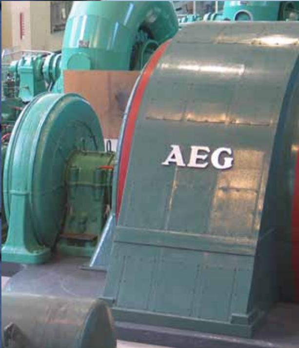
Wasserkraftgenerator mit sinusförmiger Spannung
